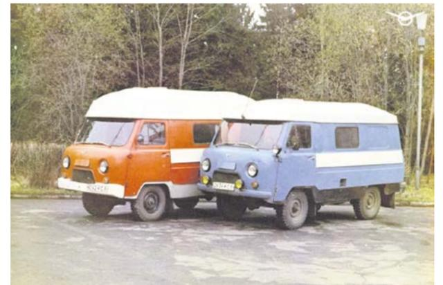
▶ Автомобиль РПК-23М для ремонтно-профилактических работ на кабельных магистралях связи, выпускающийся рембазой ТЦМС-23 г. Петрозаводска (фото из архивов завода).
